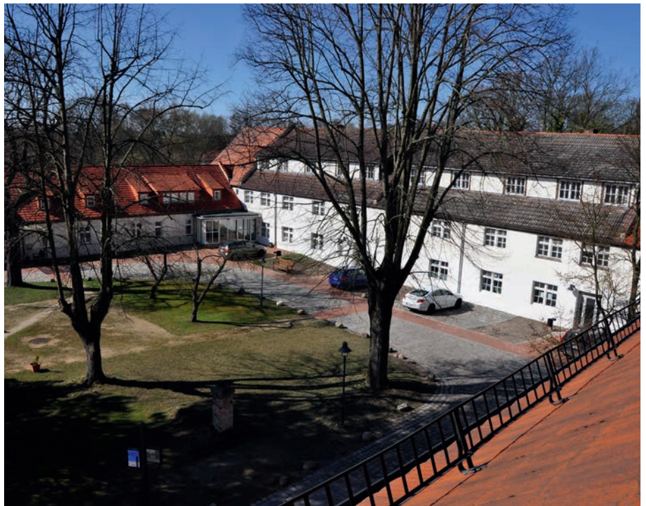
Das zum Gesundheitszentrum am Kloster umgebaute alte Krankenhaus in Lehnin
